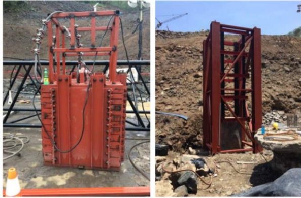
Figura 9.- Maza y guía para la ejecución de las pruebas dinámicas.
